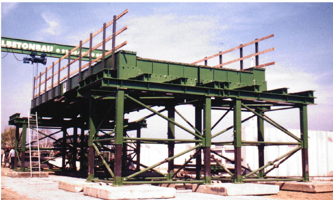
NVA-Brücke – Musteraufbau / 4,00m Fahrbahn + 2 x 0,50m Gehweg
